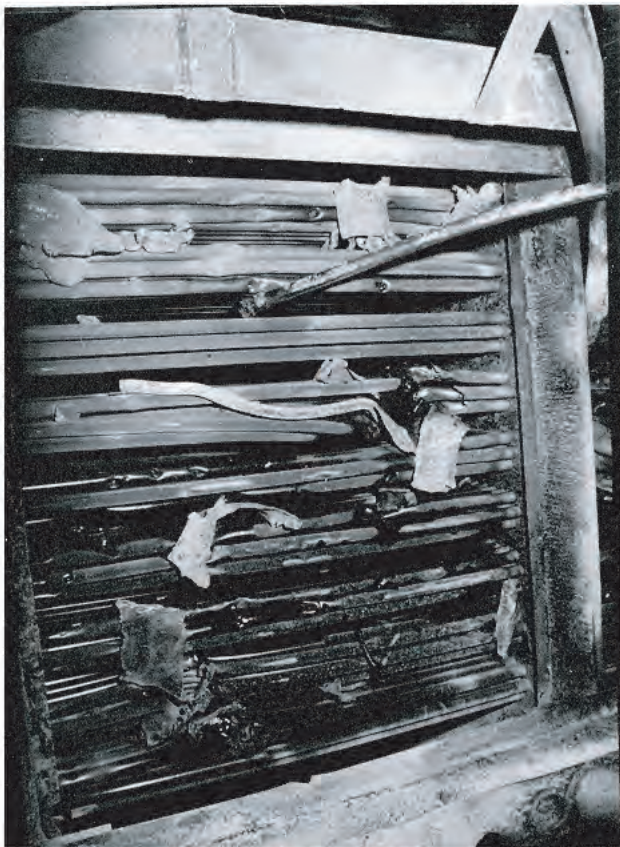
主復水器細管の破損
