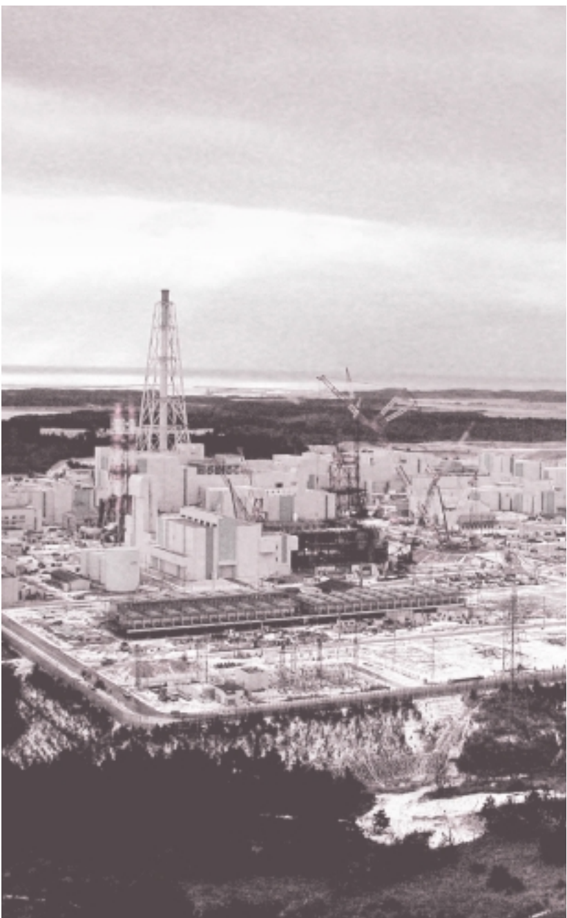
六ヶ所村で建設中の再処理工場
