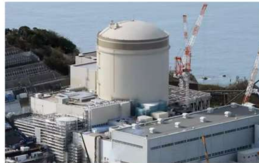
関西電力の美浜原子力発電所3号機（福井県美浜町）
