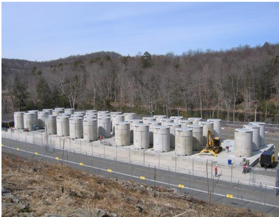
図 5 米国の電気出力56万キロワット(560MWe)のコネティカット・ヤンキー原子力発電所のサイトで残っているのはカスクだけ コネティカット川の東岸に位置する同炉は1968年から96年まで運転された。左側にある40基のカスクには、原子炉の生涯運転から取り出された使用済み燃料の90パーセント以上が入っている 48 。右端にあるカスク(この写真が撮られたときには3基だったが、現在は5基になっている)には、原子炉容器内の放射能で汚染された構造物が入っている。すべてのカスクが、国の深地下処分場あるいは地表集中中間貯蔵施設の許可を待っている。(写真:コネティカット・ヤンキー社ウェブサイトより: https://connyankee.com/fuel-storage/ )
