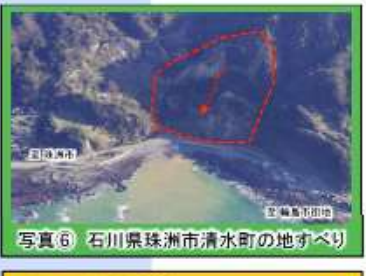
写真⑥ 石川県珠洲市清水町の地すべり
