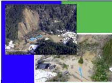
写真⑦ 河原田川(輪島市熊野町崩壊箇所)
