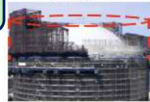
<外部遮蔽壁頂部の撤去> 2017.7~
